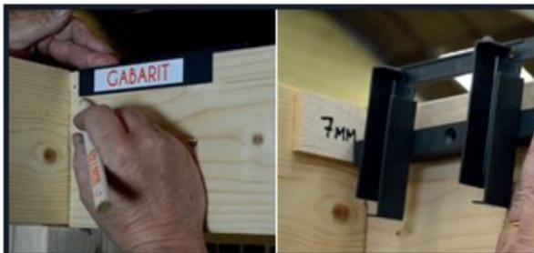
2. Positionner le kit SAM avec gabarit de 2cm au-dessus et cale de 7mm au bout de la parclose, les tringles vers le dessus.
