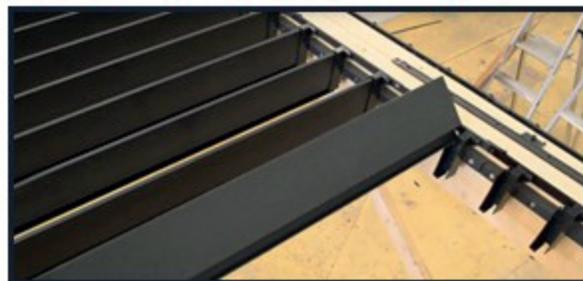
7. Soulever la languette du support pour introduire les lames. Les pousser dans leur logement, en tapant alternativement sur les côtés gauche et droit.
