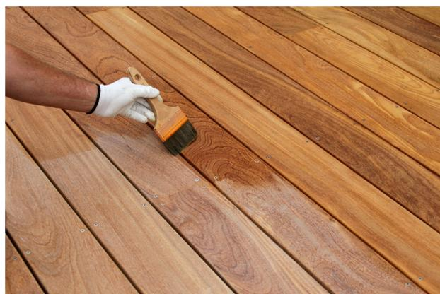
Schéma 12 : Application d'un saturateur en mars et octobre
