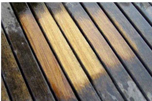
Schéma 11 : Résultat après application d'un dégriseur
