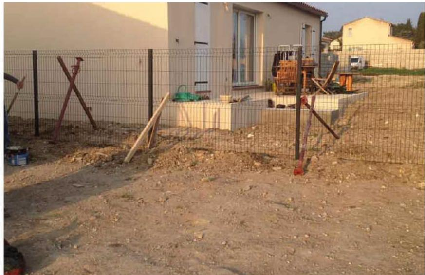
**Attention** : L'utilisation de produits prêts à l'emploi de type "Béton express" ou "turbo béton" permet de verser le béton directement dans le trou et d'y ajouter l'eau sans gâchage ni malaxage préalable.
